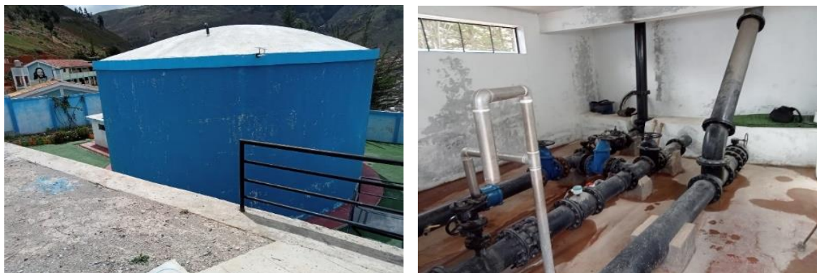
Imagen N° 19: Reservorio San Cristóbal
